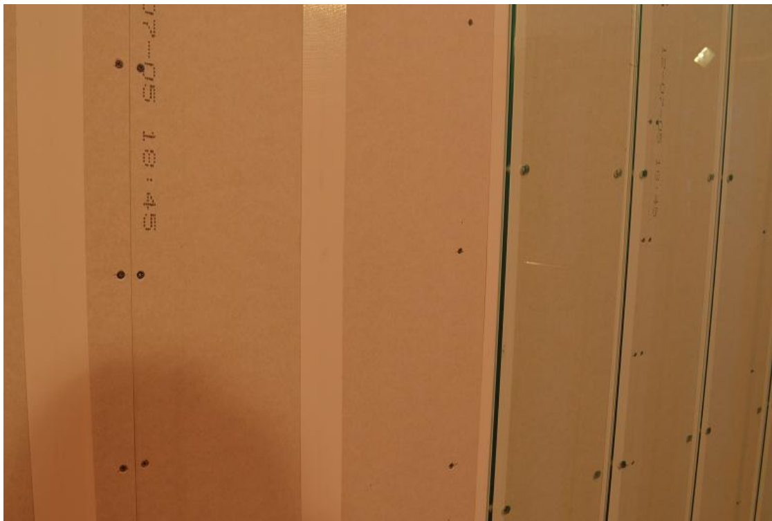
Bild 9. Väg 1 under montering.
