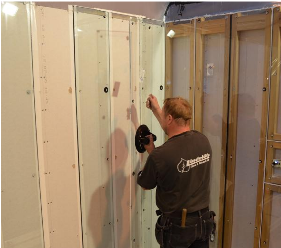
Bild 13. Byte av glaspaneler mellan vattenbegjutningsperiod 1 och 2.
