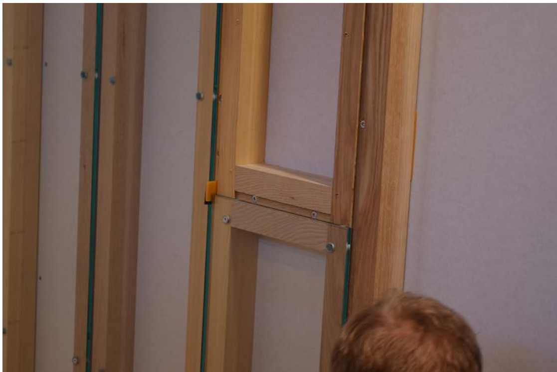
Bild 5. Pågående montering på vägg 2.
