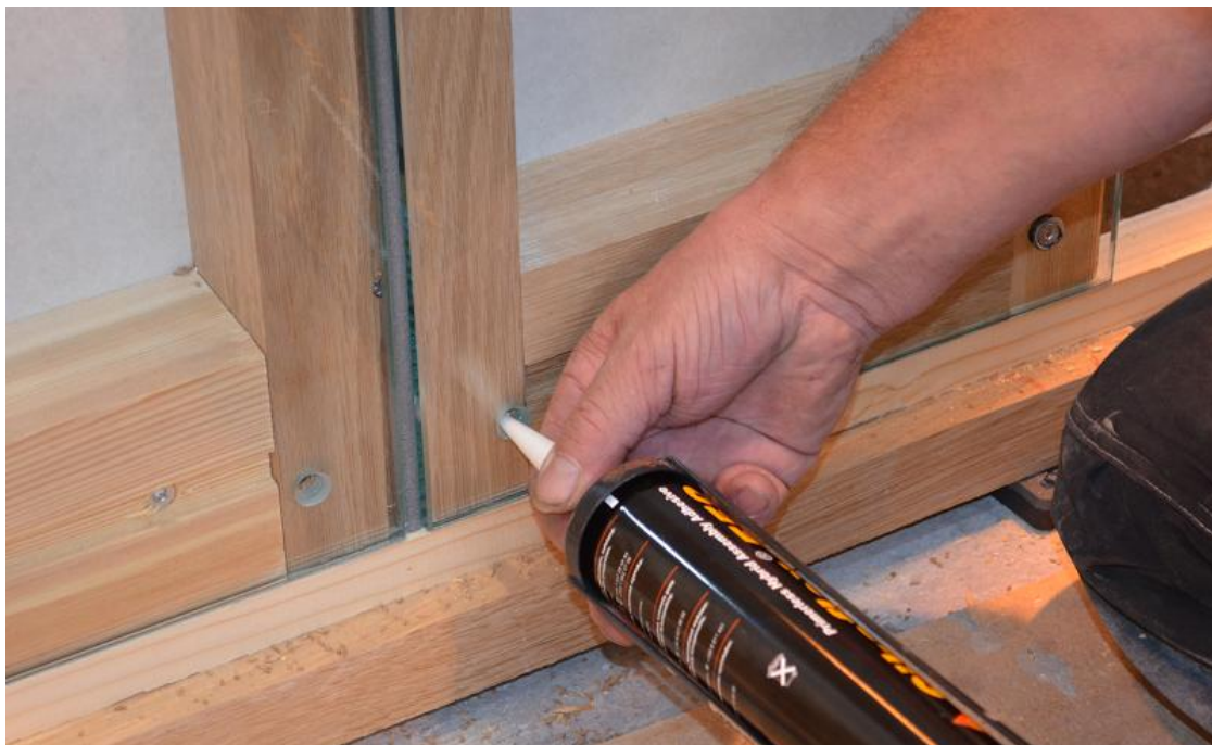
Bild 7. Infästningshål fylls med fogmassa.
