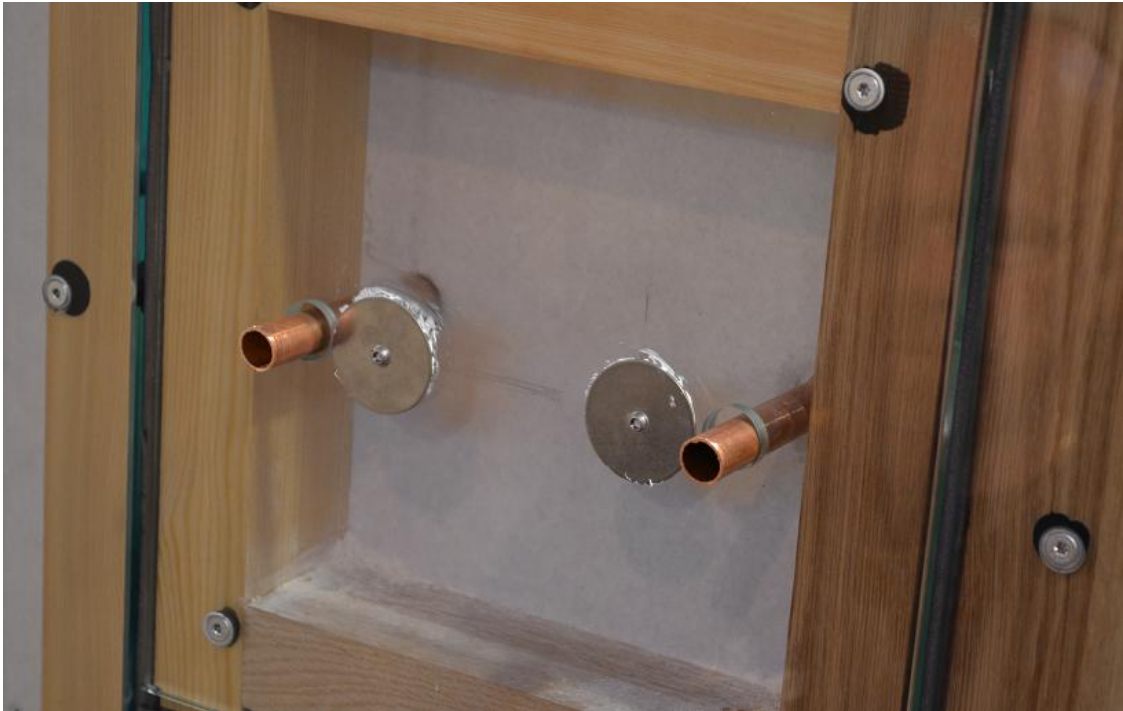
Bild 11. Vvägg 2, blandarfästen limmade mot glas och rör monterade.
