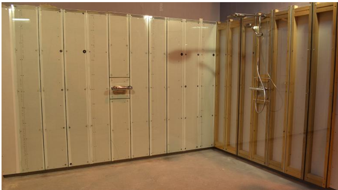
Bild 3. Glaspanelerna på vägg 1 och 2 färdigmonterade.
