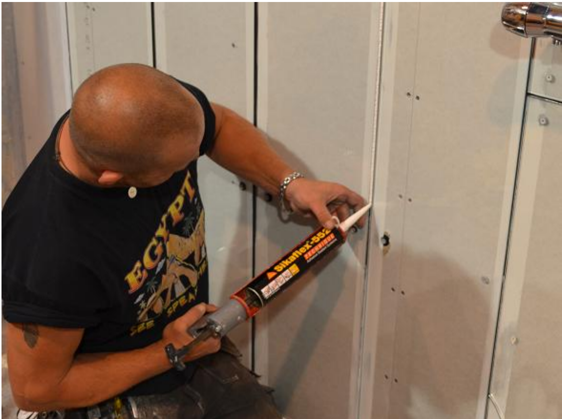
Bild 12. Fogning mellan glaspaneler.
