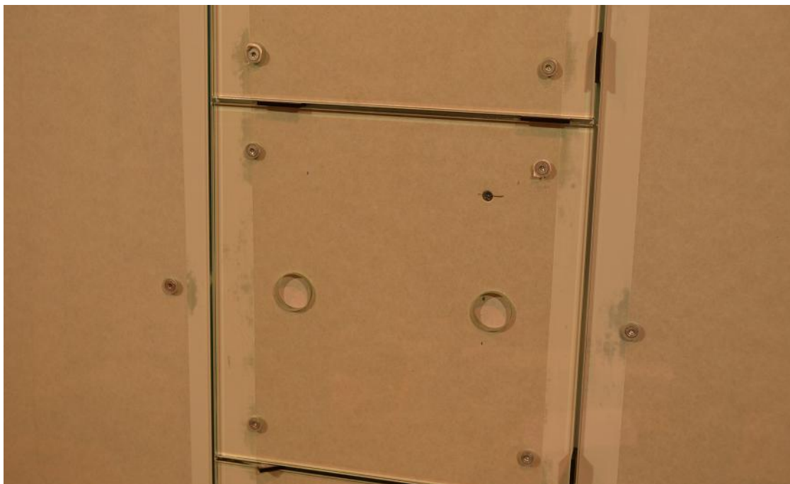
Bild 10. Väg 1, glaspanel med uttag för rör till blandare, innan fogning mellan paneler.
