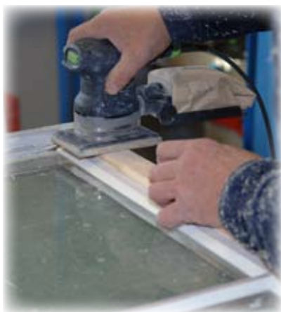
Eventuell träkomplettering, spackling och slipning
