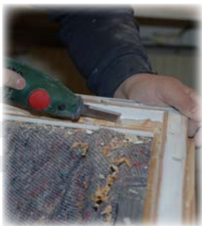
Kitt och glas avlägsnas. Bågen rengörs, slipas ren och fuktkontrolleras
