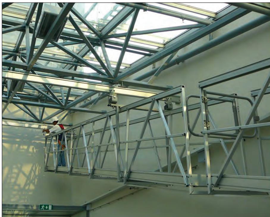
Bild 5. Exempel på invändig servicebrygga.
