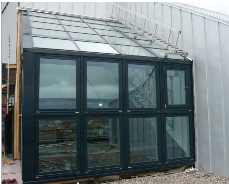
Bild 4. Exempel på utvändig servicestege på tak.
