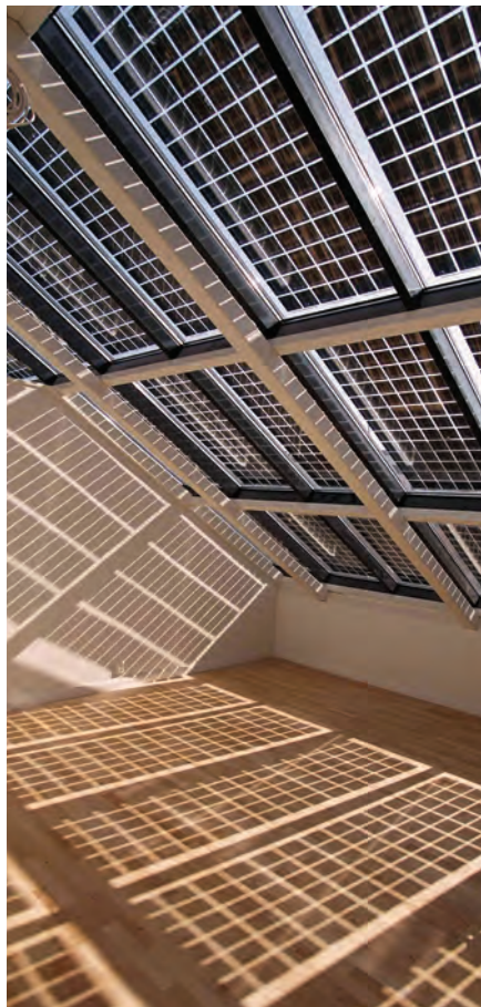
Bild 8. Semitransparenta moduler sedda inifrån. Modulerna på bilden är tillverkade av polykristallina celler som har monterats med en sådan separation att ett betydande ljusinsläpp har uppstått.
