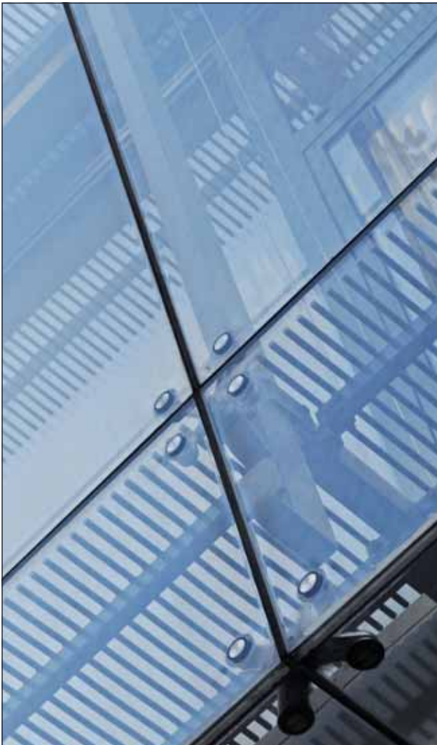
Bild 52. Detalj av bultinfästning.
