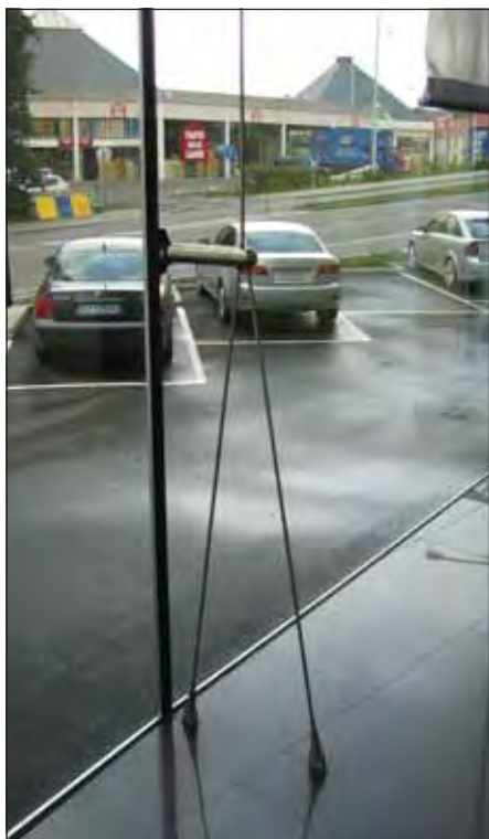
Bild 39. SG-fasad med Rodsystem. Lexus bilhall i Bryssel.
