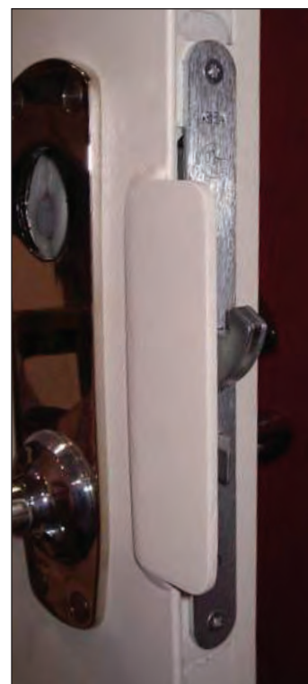
Bild 31. Låskista för motor-slutbleck, kolven i låst läge. Täckbricka för att täcka karm-urtag vid stängd dörr.
