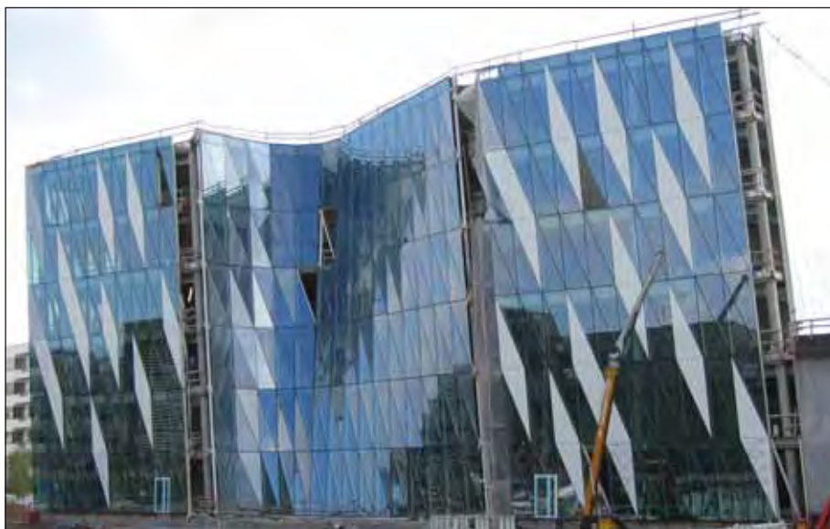
Bild 47. Helglasfasad utformad som en elementfasad. Saxo Bank huvudkontor i Köpenhamn.
