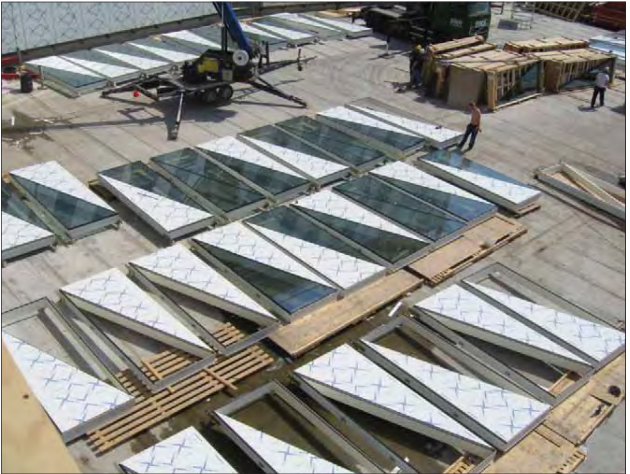
Bild 48. Triangelformade isolerrutor och sandwichelement i prefabricerade aluminium ramar. Samma fasadmönster men här distanserat.
